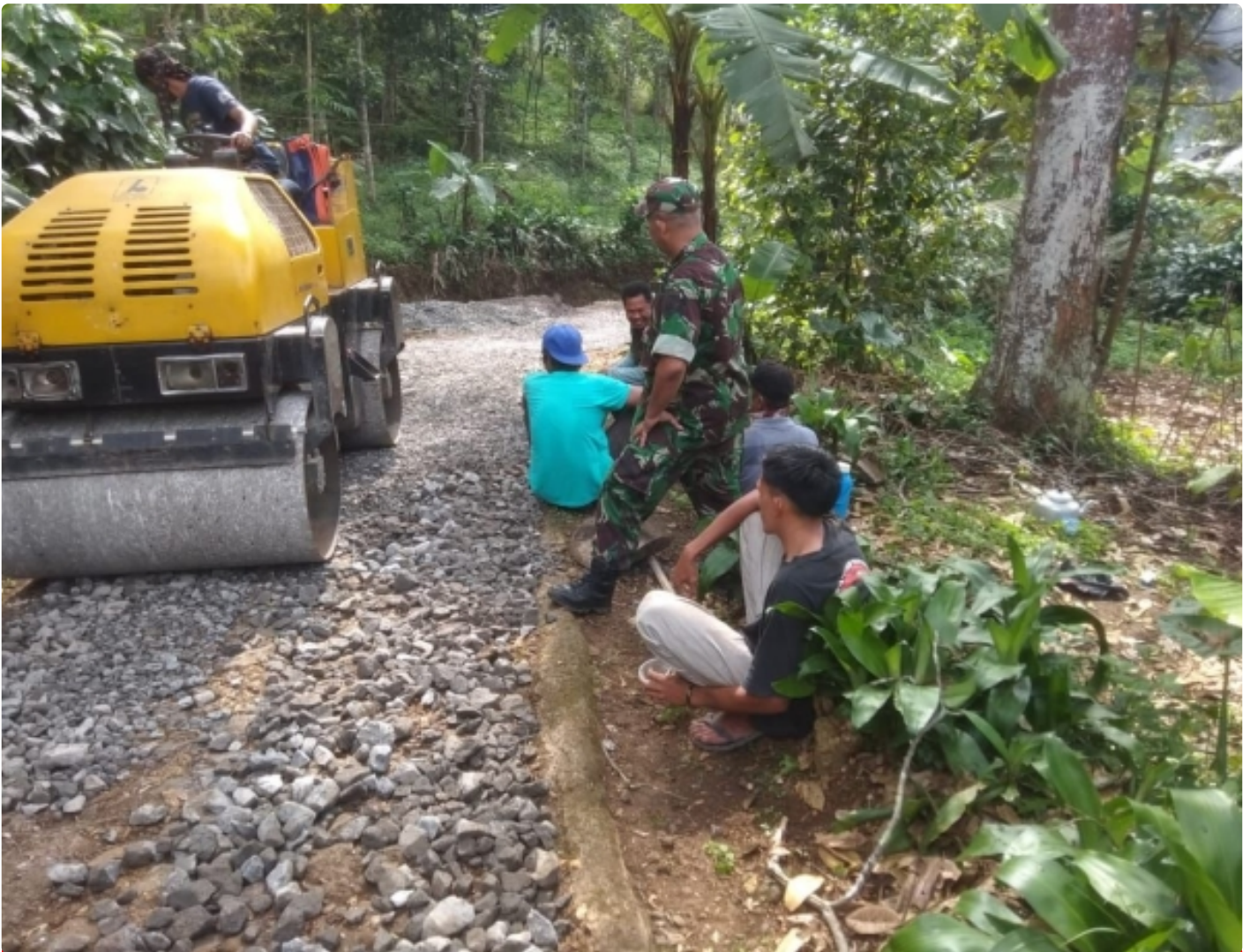
Babinsa Desa Pangkalan Monitoring Pembangunan Infrastruktur
